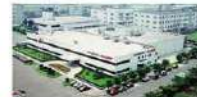
■ Planta de Manufactura en Japón (Sharp Electronics (Nagoya) Co., Ltd. (SEEL) (Nagoya))
